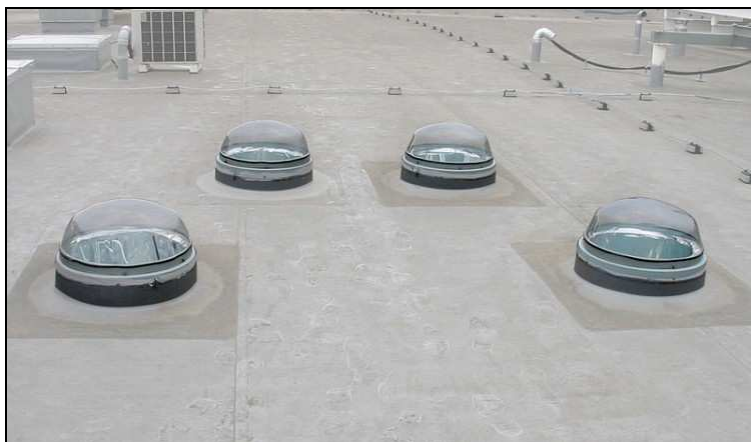
Obrázok 7 Systém pasívnych svetlovodov
